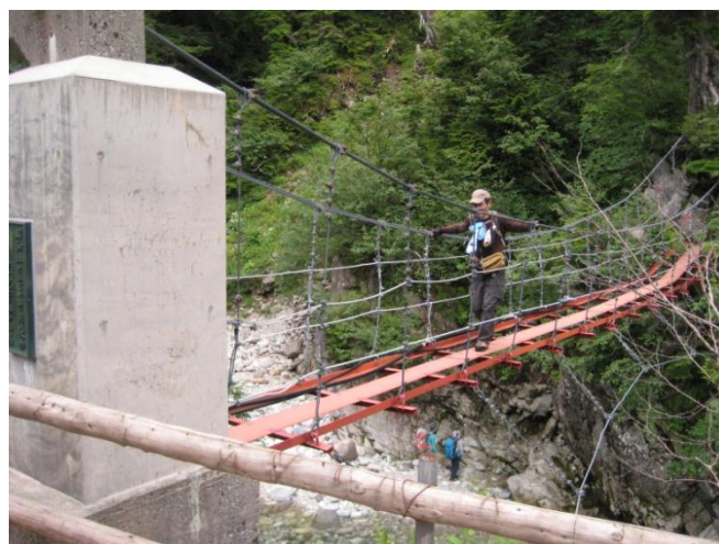
黒部川に架かる吊橋(手前 薬師沢小屋・先 雲ノ平方面)
