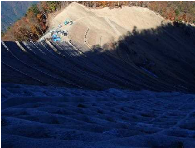
ホーキ薙 崩壊面の大工事中、現代に戻される
