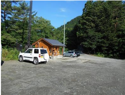
【トイレが真新しい鴨沢駐車場】
