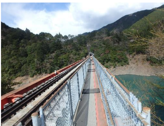
線路のとなりに遊歩道が併設
