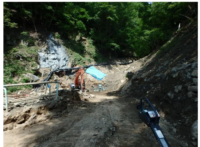
堰堤工事現場
