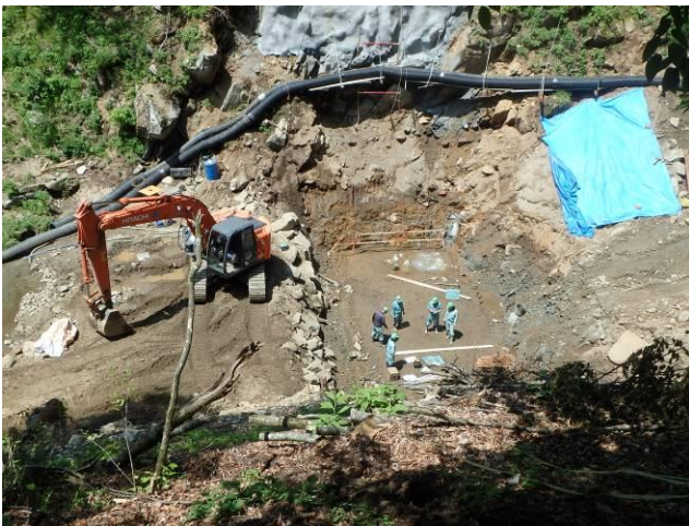
巻きルートの中から堰堤工事現場を見下す
