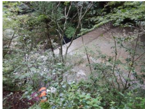
道路から見下ろした砂防ダム
